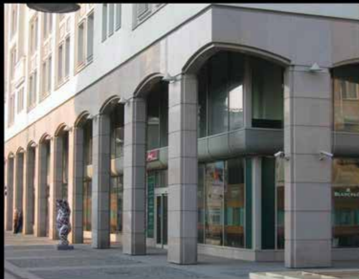
г.Москва, ул. Петровка, 5. 2005г. - наружные работы.
